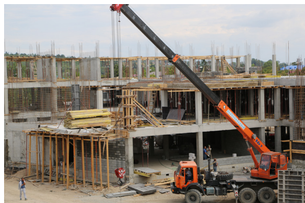
СТРОИТЕЛЬСТВО НОВОГО КОМПЛЕКСА ЮОГУ
